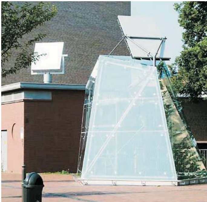
La luz se capta mediante el heliostato y se refleja hacia el interior mediante un gran panel situado sobre el lucernario y formado por 24 espejos secundarios.
