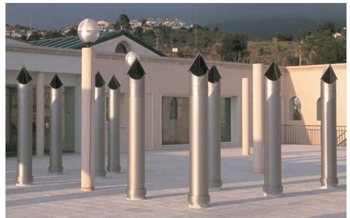
La luz se capta mediante los conductos para iluminar las aulas situadas bajo la terraza
