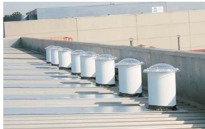
La luz del sol se transporta por los conductos de 2 metros de longitud hasta las oficinas
