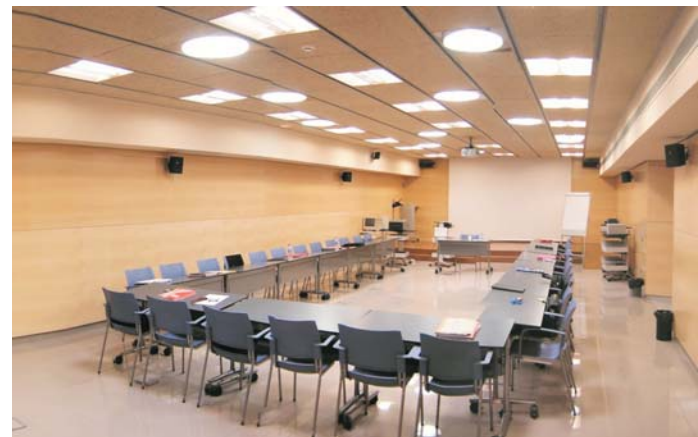
El aula sin ventanas se ilumina a través de 12 conductos de sol DSC-500
