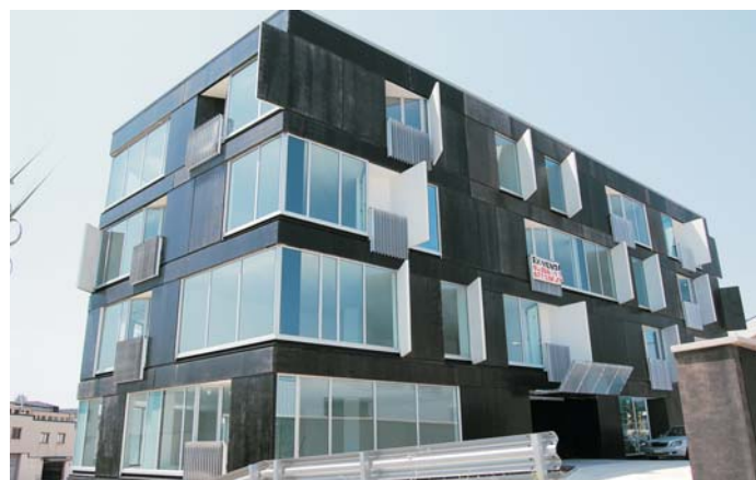
El edificio de los arquitectos Manuel Bailo y Rosa Rull de ADD+ARQUITECTURA ha sido finalista de los premios FAD de arquitectura 2008.
