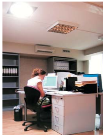
Una de las zonas de oficinas iluminadas mediante los lucernarios tubulares.
