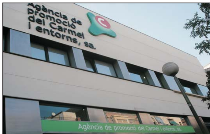
Los conductos de sol llevan la luz desde la cubierta tipo industrial hasta las oficinas
