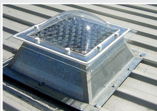
Zócalo metálico en nave industrial
