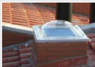
“Chimenea” de obra en edificación
