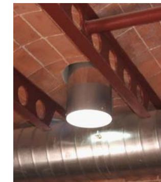
(C) DIFUSOR COLGANTE (¡A MEDIDA!) Para techos curvos e inclinados
