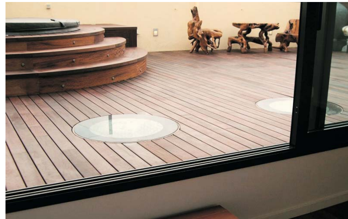
Los lucernarios captan la luz del sol quedando perfectamente enrasados al pavimento
